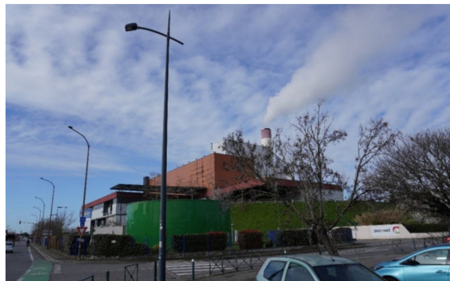
Figure 3 : L'UVE de Toulouse vue depuis la route de Seysses
