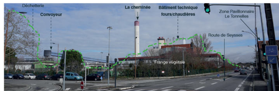
Figure 13 : Vue depuis l'intersection de la rue Paul Rocache
