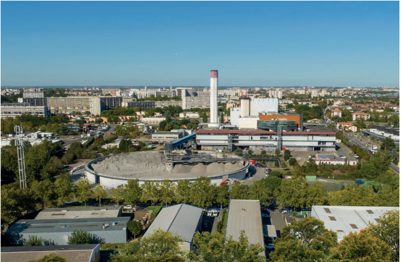
État existant : l'UVE actuelle
