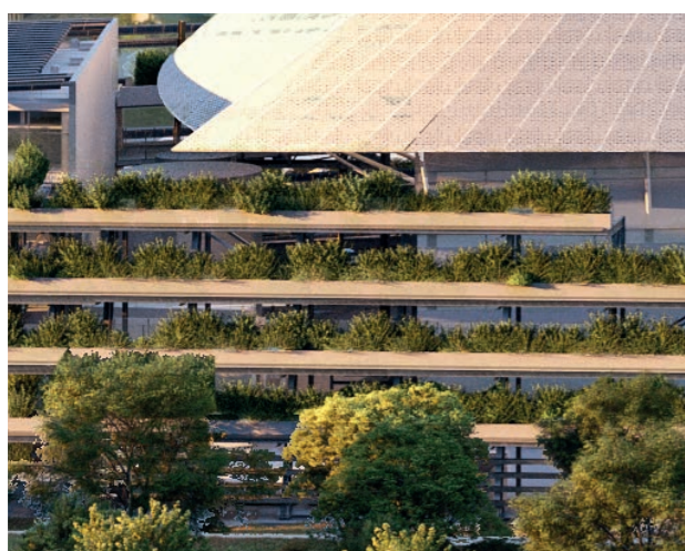
10 Bac planté métallique sur structure métallique
