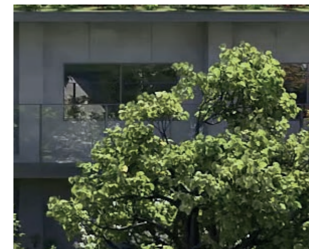
9 Béton apparent strié en joints creux
