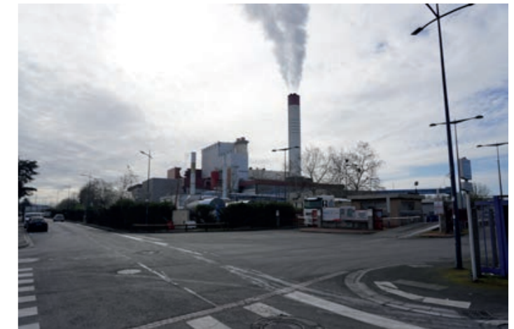
Photographie de l'angle nord-est de la parcelle
