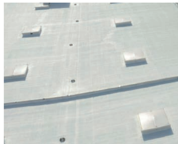
6 Toiture en bac acier
