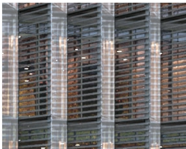
5 Façade adresse Espace Agora
