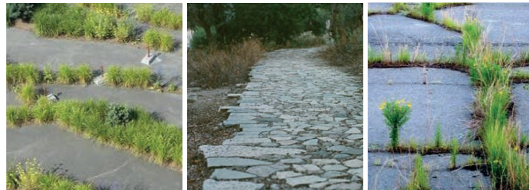
Images de références de béton concassé et pose en opus-incertum à joints enherbés, pour l'allée du jardin
