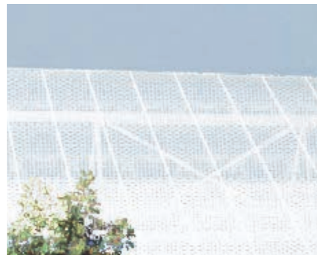
2 Sur-toiture en PTFE blanc perforé à 15% sur structure métallique
