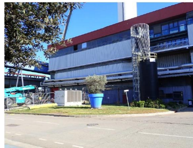
Figure 58 : Centre de valorisation des déchets urbains et UVE sur le site d'étude
